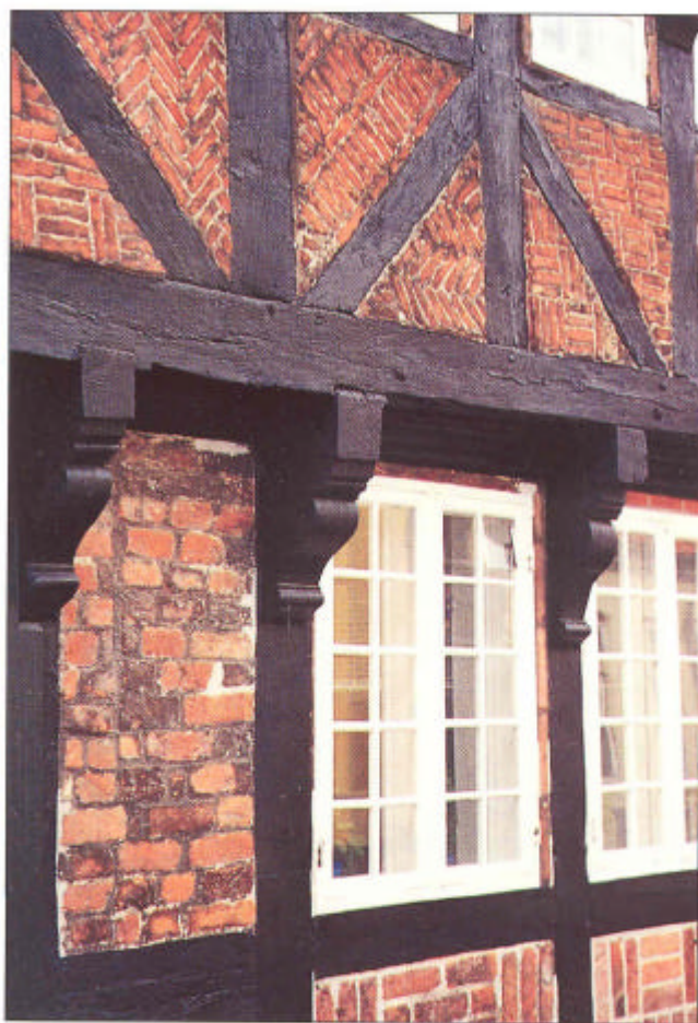
2 eksempler på bindingsværkshuse, begge med mønstermuret udfyldning i tavlene. T.v. er træ og murværk kalket i samme farve, medens bygningen t.h. har blankt murværk og sorttjæret træ.
