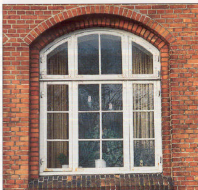
Facade med en enkel, men effektiv udsmykning i form af tilbagelegte vinduesfalske.
