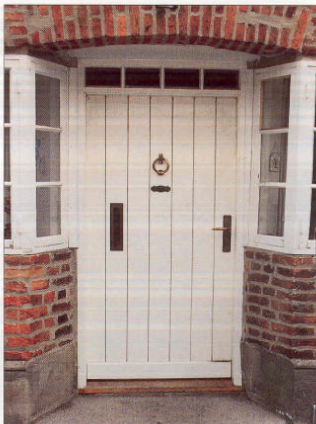
Revledøren med lodretstående planker har altid været almindelig som bagdør, og bør stadig anvendes som sådan. Enkelte steder er dørtypen også brugt som fordør.
